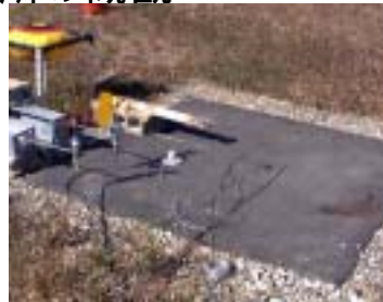
( ) アスファルト舗装面
